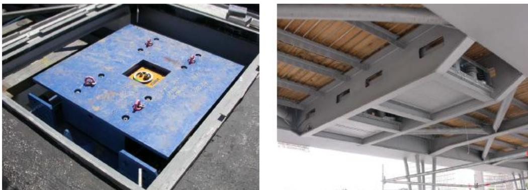
Figura 4.22 - Exemplo da aplicação de TMD's (HiVoSS, 2008)
