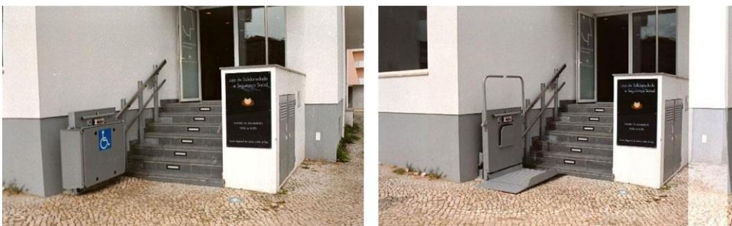
Figura 7.3 - Elevador de escada – adaptado de (Escada Fácil, 2010)
