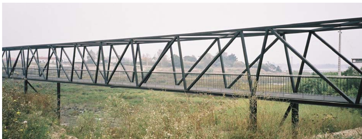
Figura 8. Ponte pedonal – tramo intermédio.
