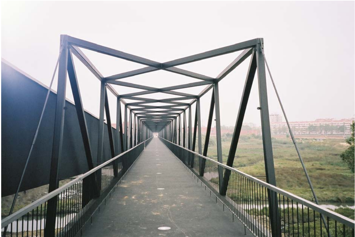
Figura 10. Ponte pedonal – vista do interior.
