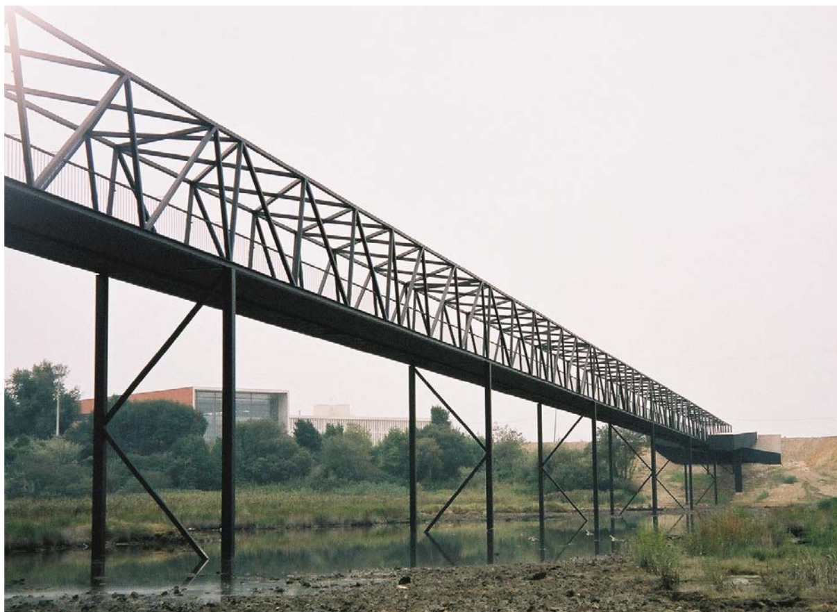
Figura 9. Ponte pedonal – vista de baixo.
