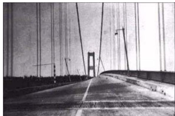
Fig.14 e Fig.15 – Imagens da instabilidade ocorrida no acidente de Tacoma, [3]
