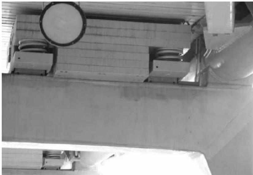
Fig.78 – Imagem de um amortecedor de massa sintonizado, [21]
